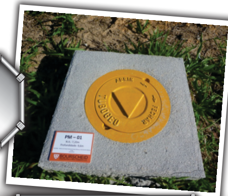
Poço de monitoramento de água subterrânea sendo instalado (à esquerda) e concluído (à direita). Fonte: Bourscheid (2013)
